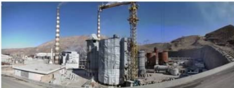
پروژه احداث كارخانه اسيد سرچشمه
